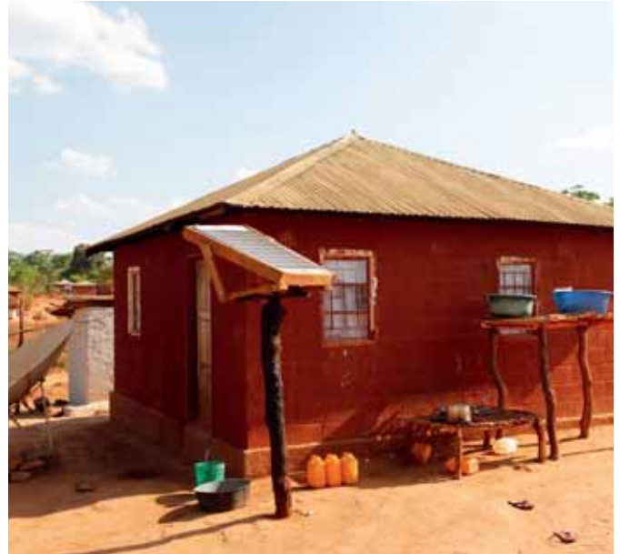
Im Zuge der Modernisierung der Infrastruktur wurden 24 neue Häuser für die Ranger des Nationalparks gebaut.
