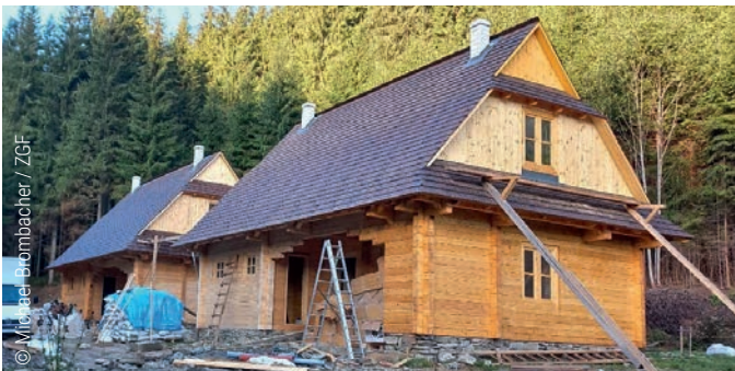
Im ukrainischen Verkhovynskyi-Nationalpark, nahe der rumänischen Grenze, wurden hochwertige Rangerhäuser gebaut, die sich an traditioneller und nachhaltiger Architektur orientieren. Ein zweites Gebäude dient als Gästehaus für Touristen.
