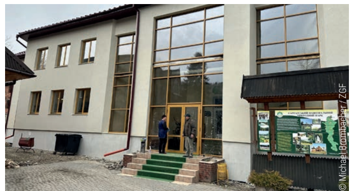
Das Verwaltungsgebäude des Karpaten-Nationalparks in der Stadt Yaremtsche wurde renoviert. Es wurden neue energieeffiziente Holzfenster eingebaut und die Außenwände gedämmt. Durch die Renovierung konnten die Energiekosten des Nationalparkgebäudes erheblich gesenkt werden. Derzeit werden Heizungsrohre und Heizkörper modernisiert und Büroräume renoviert.
