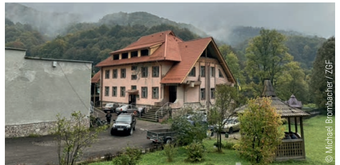
Das Hauptverwaltungsgebäude des Karpaten-Biosphärenreservats wird derzeit renoviert. Das undichte Dach wurde repariert und ersetzt.
